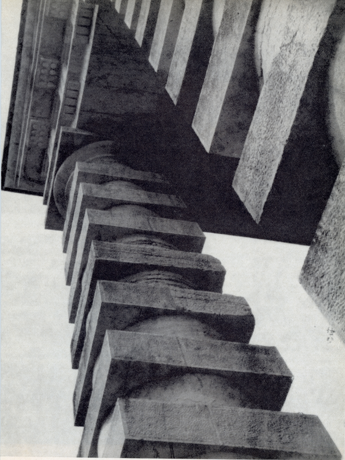
Les Salines de Ledoux. Détail du bâtiment central. Arc et Senans (Doubs).
