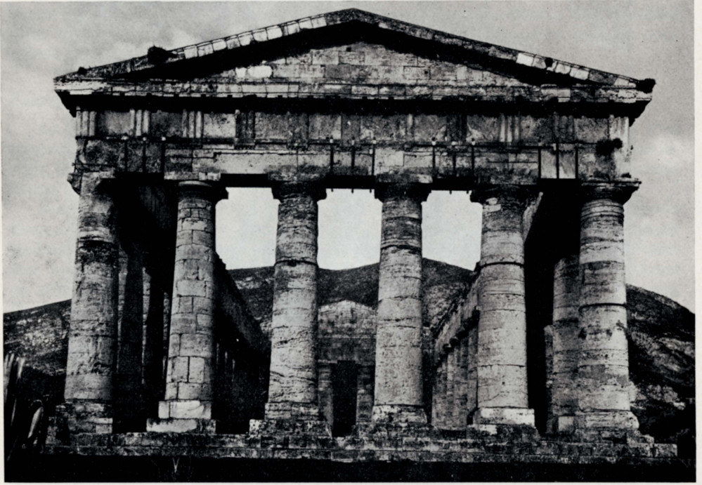
Temple dorique hexastyle péripète de Ségeste (Sicile) à 36 colonnes hautes de 9,30 m. et de 1,92 m. de diamètre à la base.
